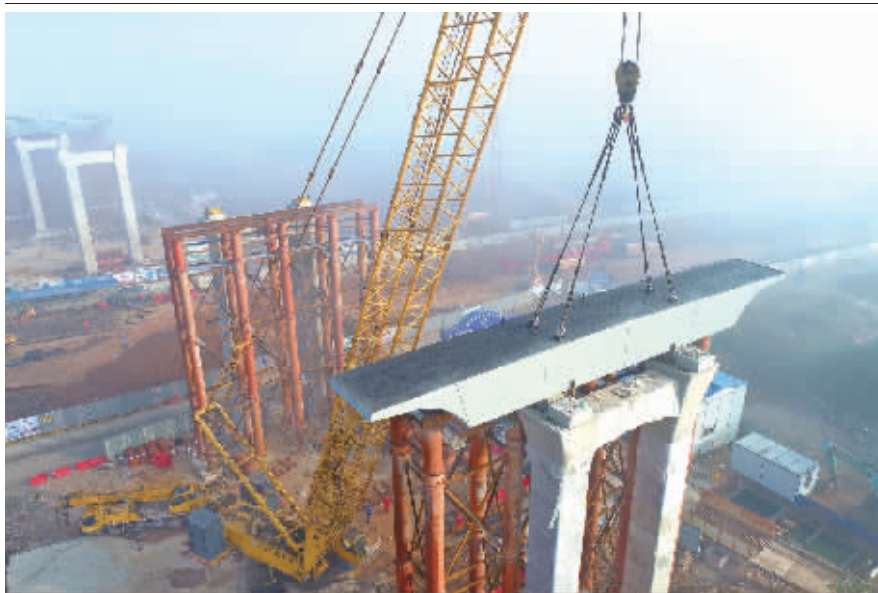
11月26日，随着首块50吨重的钢箱梁被大型起重机械平稳吊至桥墩上，长沙湘府路快速化改造工程红旗路立交进入钢箱梁吊装阶段。红旗路立交是湘府路快速化改造工程的关键性节点工程，计划明年春节前完成首联钢箱梁安装工作。 记者 徐行 摄影报道
