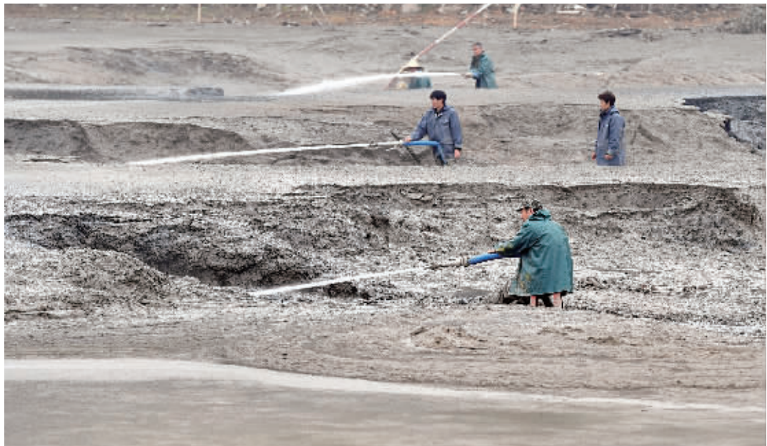
11月15日下午,长沙岳麓区后湖,施工人员进行塘体清淤。 记者 田超 摄
