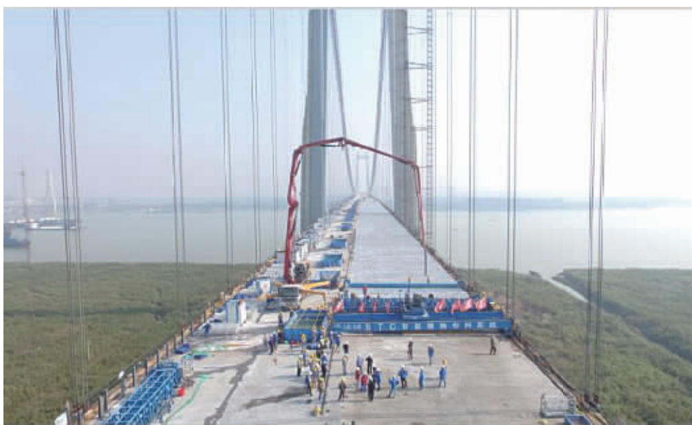
近日，岳阳洞庭湖二桥完成了超高韧性混凝土(简称STC)最后一段浇筑。和普通桥面不同，STC桥面可实现终身无需大修的超长寿命，这座世界第二、国内第一大跨径的钢桁梁悬索桥预计今年年底竣工通车。 雷谊 摄
