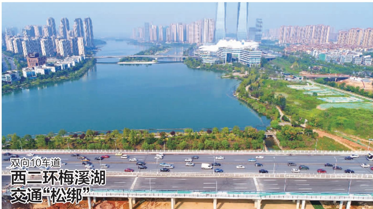
9月18日,长沙西二环龙王港大桥东扩工程完成最后的桥面沥青摊铺和地面标线。该工程将龙王港大桥东扩18米,达到宽度为54米,满足机动车辆双向10车道通行需求。新桥竣工通行后,将改善西二环梅溪湖片区交通瓶颈。 记者 徐行 摄
