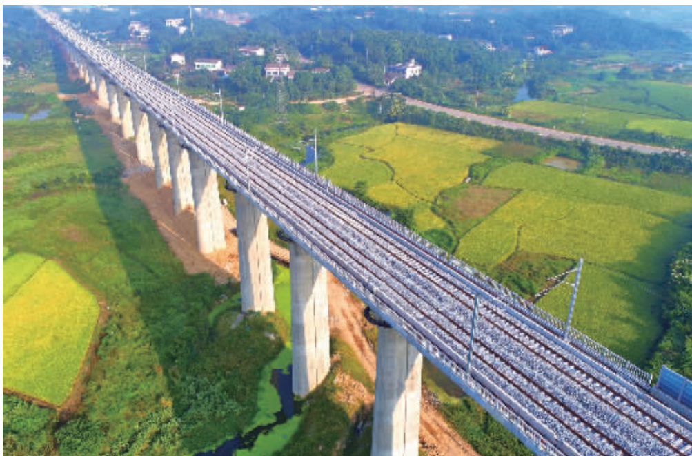
9月17日,空中俯瞰长沙市望城区长株潭城际铁路西延线高架桥,好似“蛟龙”横卧大地。当天,长株潭城际铁路西延线全线长钢轨焊接全部完成,为年底按期开通运营奠定了基础。 记者 徐行 通讯员 赵飞 摄影报道
