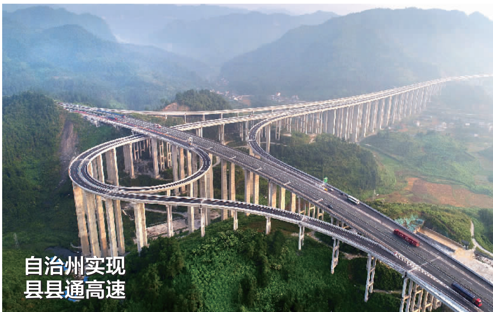
9月15日,俯瞰永吉高速公路石家寨互通。当天,永(顺)吉(首)高速公路古丈至吉首段建成通车。至此,湘西土家族苗族自治州实现了县县通高速。永吉高速主线长84.557公里,连接线长20.585公里。全线共有桥梁106座、隧道14座,是全省在建高速公路施工难度最大的建设项目。
