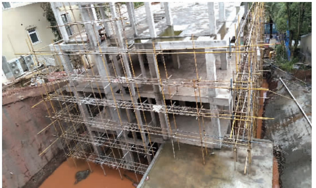
9月11日上午,在长沙市圣爵菲斯小区棕榈片区,V3栋别墅的重建工程已停工,楼房也从原有的三层改扩建到了五层。 记者 杨昱 摄
