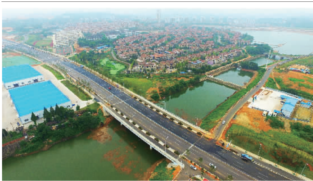
长沙市开福大道北段(凤羽桥至三环线)日前已基本完工，正在进行最后的下穿绕城线的限高架施工。开福大道新修段南起捞刀河大桥，途经苏垅生态新城、高岭商贸组团，北至三环线，全长8.51公里，预计下月可建成通车。届时，长沙城区将再添一条南北向大动脉。
