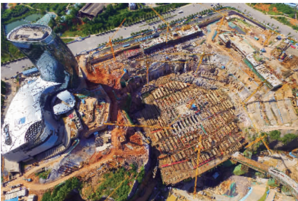
8月17日，正在施工中的湖南湘江新区湘江欢乐城冰雪游乐项目。从2014年开始，来自施工单位中建五局土木公司的一群人先后攻克爆破及锚索施工难题，将不可能变为可能。 记者 田超 摄
