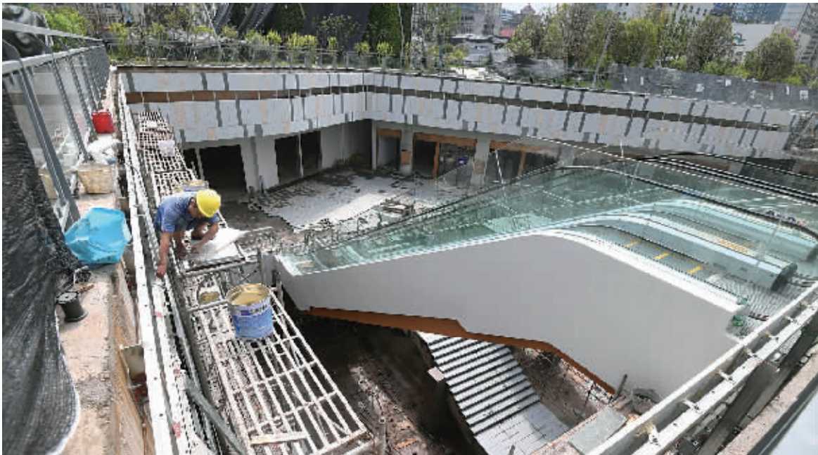
8月15日,长沙市五一广场,地下商业广场部分正在加紧进行内外装饰。 记者 田超 摄
