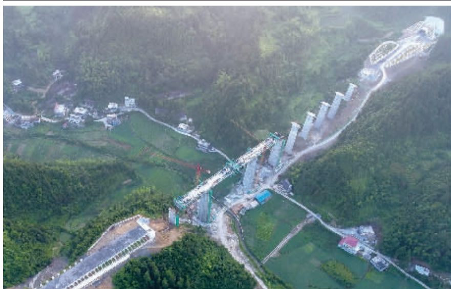
8月7日凌晨,位于龙山县红岩溪镇尧城村的黔张常(重庆—张家界—常德)铁路尧城大桥首跨连续梁合龙。尧城大桥全长417.88米,共9个桥墩,2个桥台,总投资3353万元。
