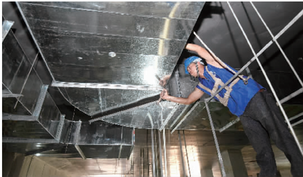
8月4日，长沙地铁3号线洋湖湿地站，施工人员进行站厅层风管安装的扫尾施工。 记者 田超 摄
