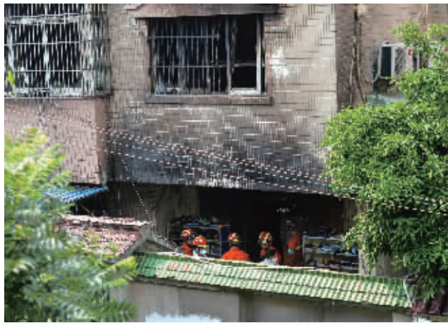
7月16日,工作人员在火灾事故现场忙碌。新华社图
