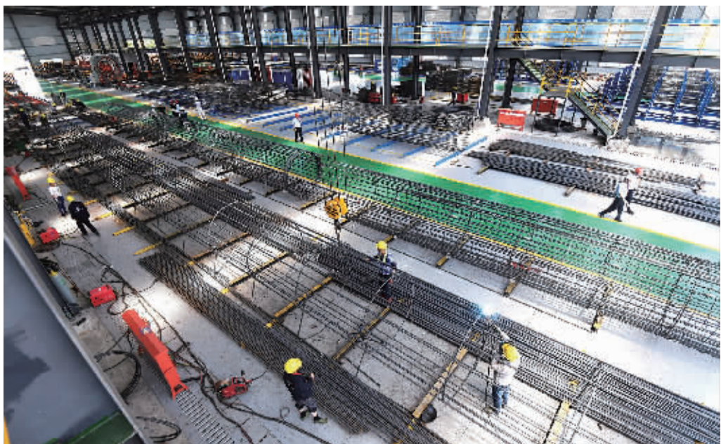
7月14日,中铁大桥局集团湘府路快速化改造工程一标项目经理部装配式桥梁预制厂,工人在制作桩基钢筋笼,将用于湘府路快速化改造工程建设。 记者 田超 摄
