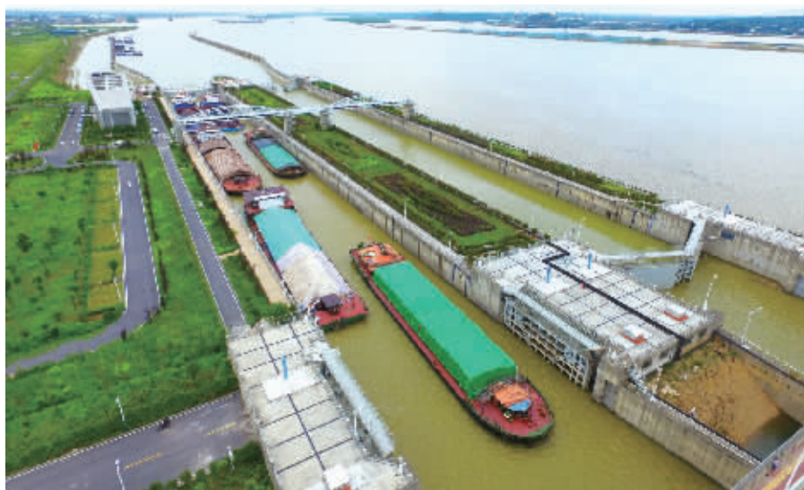
7月10日,湘江长沙综合枢纽,几艘货船有序通过2号船闸。记者 田超 摄
