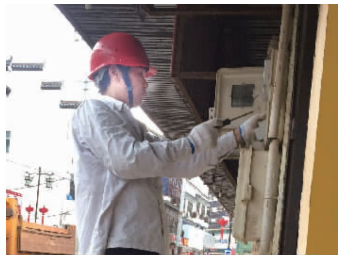
7月6日下午,张灿辉在长沙县梨梨集镇更换灾后受损的电表。
