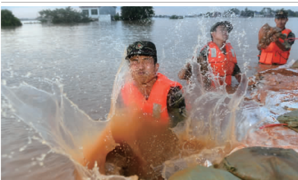
7月3日下午,武警战士在洪水中用沙袋封堵管涌。当天,长沙市望城区乌山镇团山湖八曲河大堤突发10多处管涌险情,武警长沙市支队立即组织紧急抢险。 记者 郭立亮 通讯员 邓慧 摄
