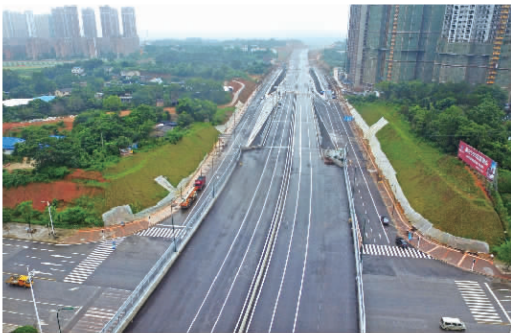
6月26日，长沙市星沙联络线万家丽跨线桥以西路段主体已施工完毕，达到通车条件。 记者 李健 摄
