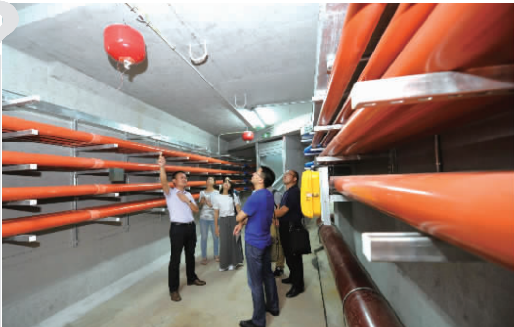
今年,长沙计划建61公里地下综合管廊。图为建设中的东四线管廊。
