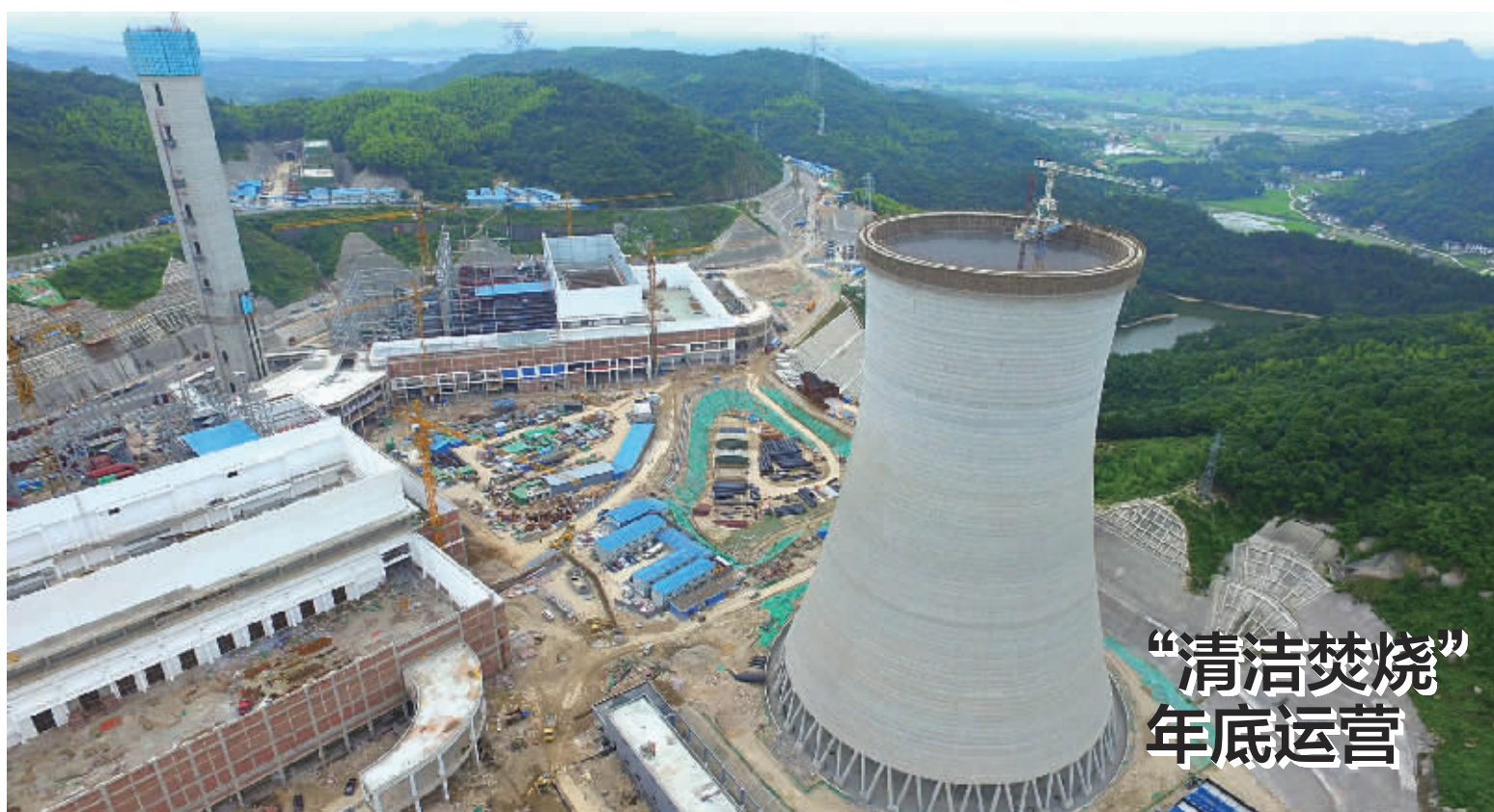
6月9日, 长沙望城区, 长沙市生活垃圾深度综合处理(清洁焚烧)项目建设现场, 125米高的冷却塔和180米高的烟囱已完工, 焚烧炉生产线开始安装, 计划年底投产运营。投产后可每天处理生活垃圾5000吨, 年上网发电量为4.14亿度。届时, 长沙将逐步告别垃圾填埋时代, 实现垃圾科学清洁处理。 记者 徐行 摄
