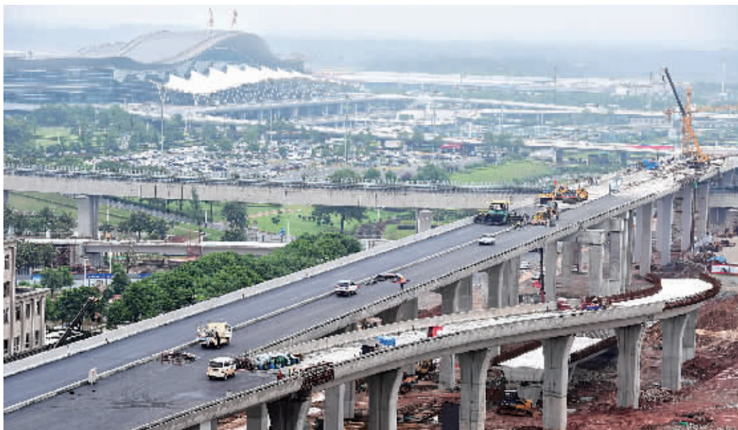
6月2日上午，长沙机场大道提质改造项目现场，中铁七局施工人员进行主线上高架桥路面沥青层、桥梁亮化以及防撞墙等施工。 记者田超 通讯员冯晓哲摄
