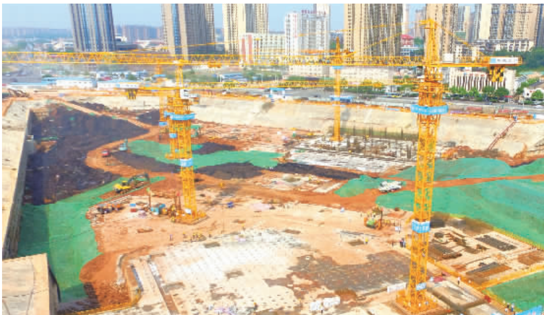
5月16日,长沙汽车南站综合交通枢纽建设现场,工人们在基坑底进行底板钢筋绑扎及防水施工。
