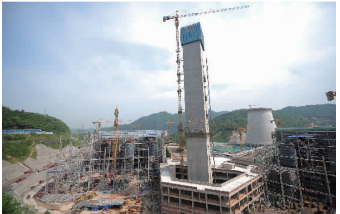
5月10日,长沙市生活垃圾深度综合处理(清洁焚烧)项目正在建设中,预计年底建成试运营。
