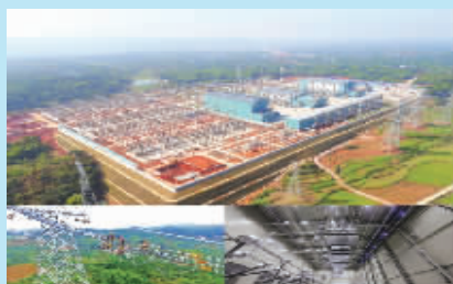
全方位支撑特高压工程建设
