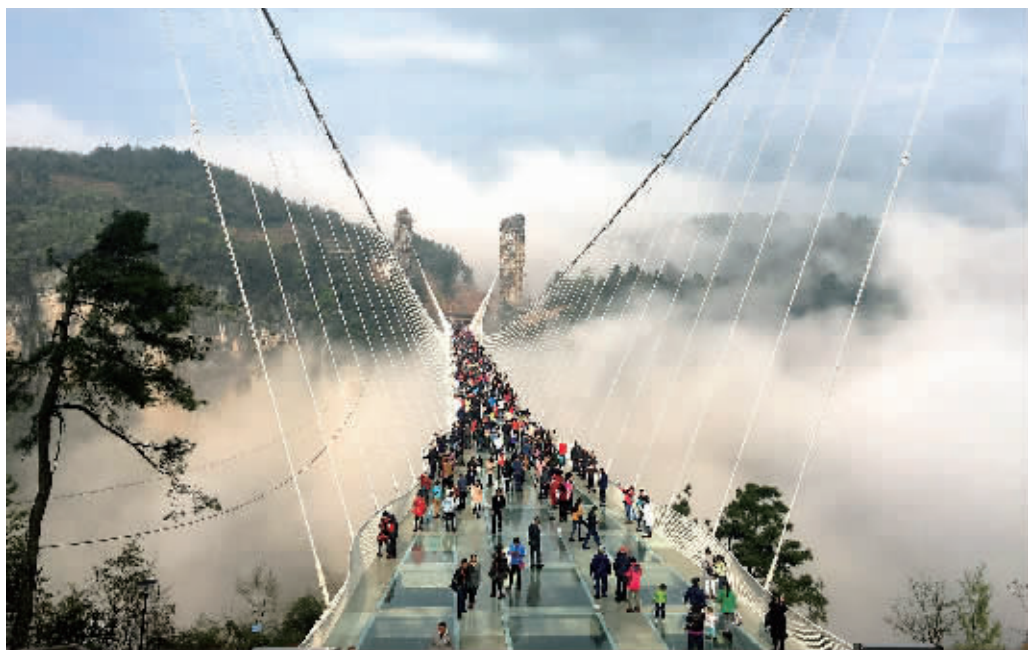
4月4日,游客在玻璃桥上游玩赏景。当天,张家界武陵源天子山景区及张家界大峡谷风景区出现雨后放晴的云海景,山峰、房屋、公路、树木、桥梁等在云雾中若隐若现。
