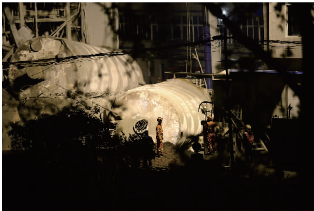
3月30日，湖南建坤混凝土公司坍塌事故现场，消防队员正在组织救援。辜鹏博 摄
