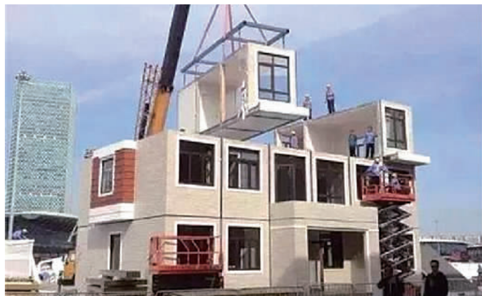
像搭积木一样盖楼,不但能降低建房成本,还可以提高建筑质量和效率。
