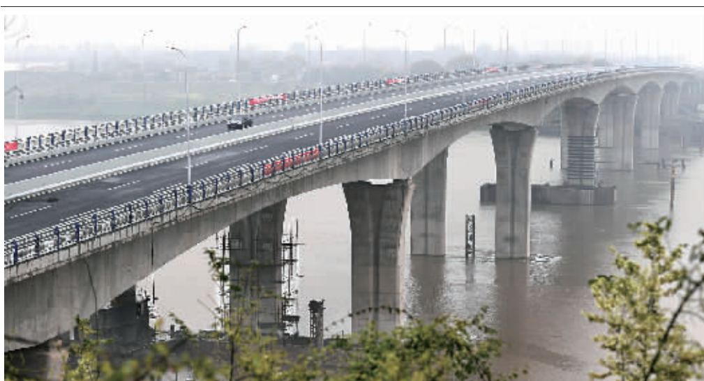
3月21日上午,新建的株洲湘江七桥(渌口大桥)全面放开交通,标志着株洲又添新的过江通道。该桥属于连续箱梁桥,东桥头位于株洲县渌口镇南约3公里处,西桥头位于株洲市天元区雷打石镇境内,设计为双向六车道。 记者 田超 摄
