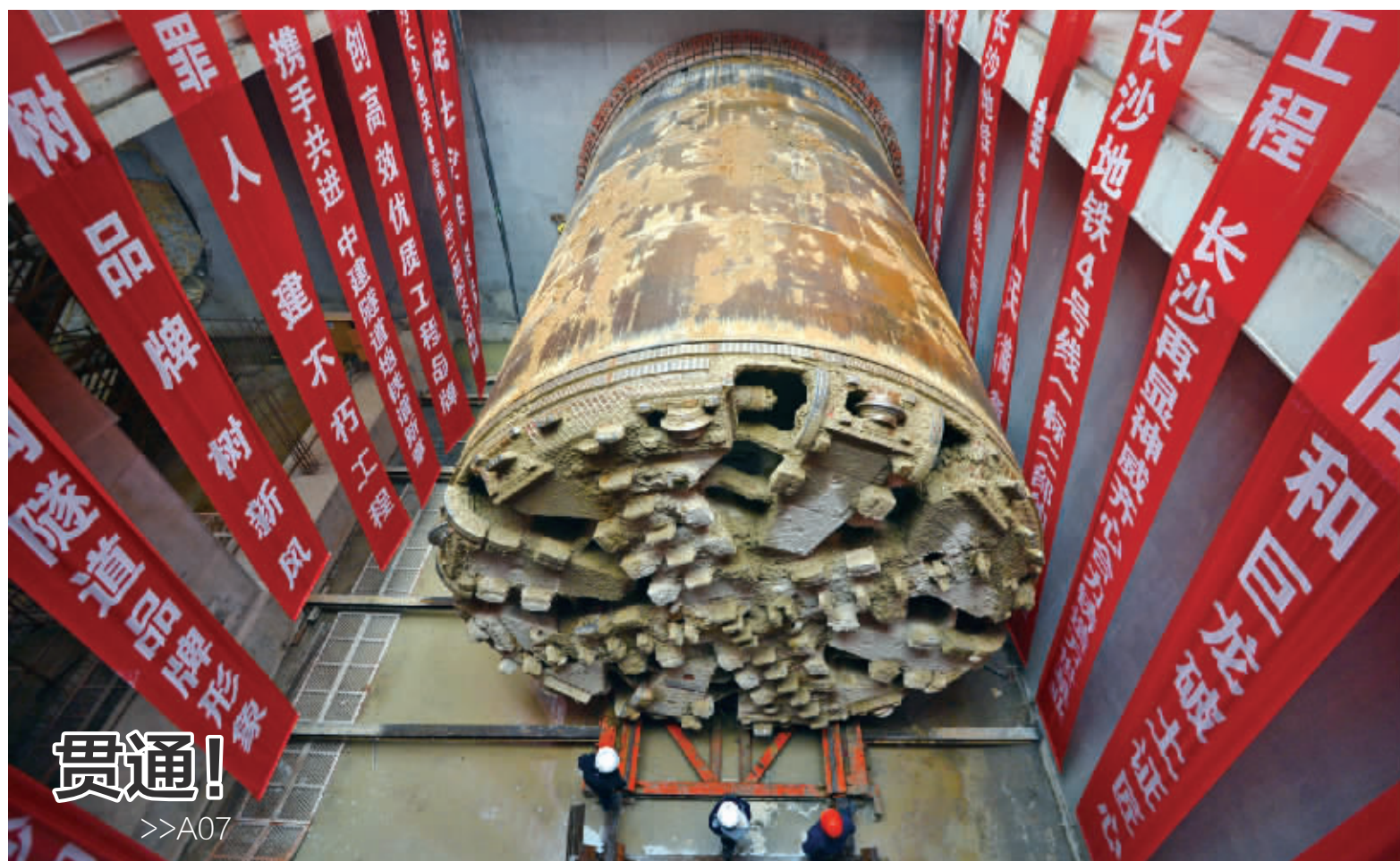
2月22日,“信和”八号盾构机从湘江新城站破土而出,标志着长沙地铁4号线一期工程湘江新城站至汉王陵公园站右线顺利贯通,是4号线河西段首条实现贯通的盾构区间。 记者 李健 通讯员 靳晴 摄
