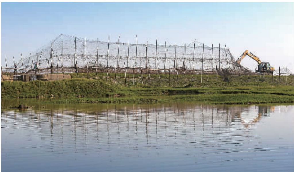
12月16日，沅江市灤湖芦苇场，工人正在操作挖机拆除钢丝网围。当天，在该芦苇场成功拆除一个长约3.4万米、高约4米的违法钢丝网围。 记者 唐俊 摄
