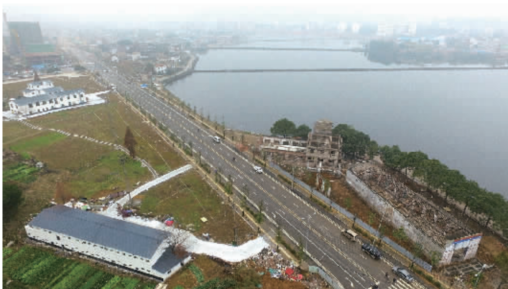
12月13日,长沙市后湖景区,几栋临湖建筑在进行改造。 本版图片均由记者 田超 摄
