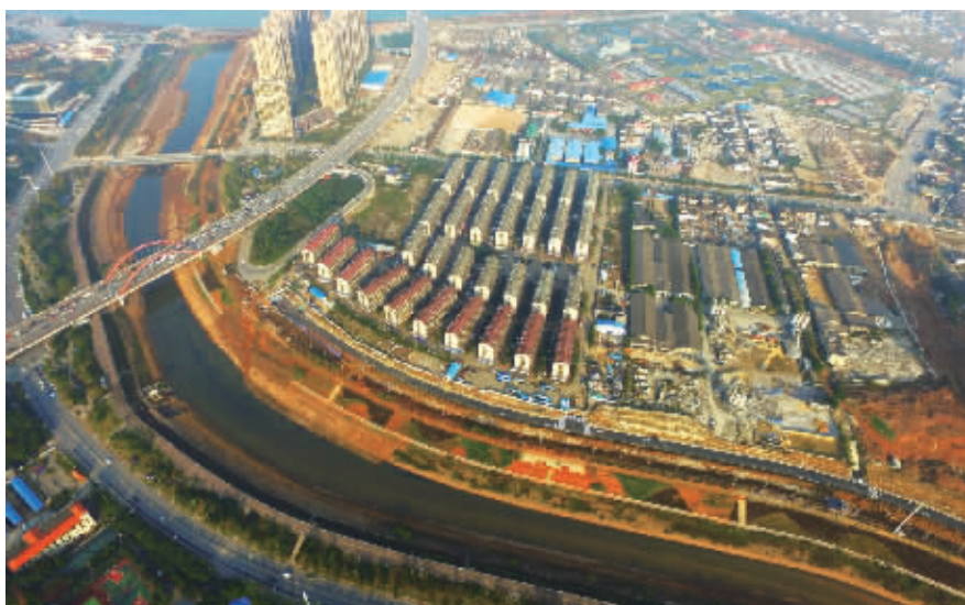
12月5日下午，长沙市圭塘河人民路大桥段，河床内的淤泥已初步清理干净。 记者 田超 摄
