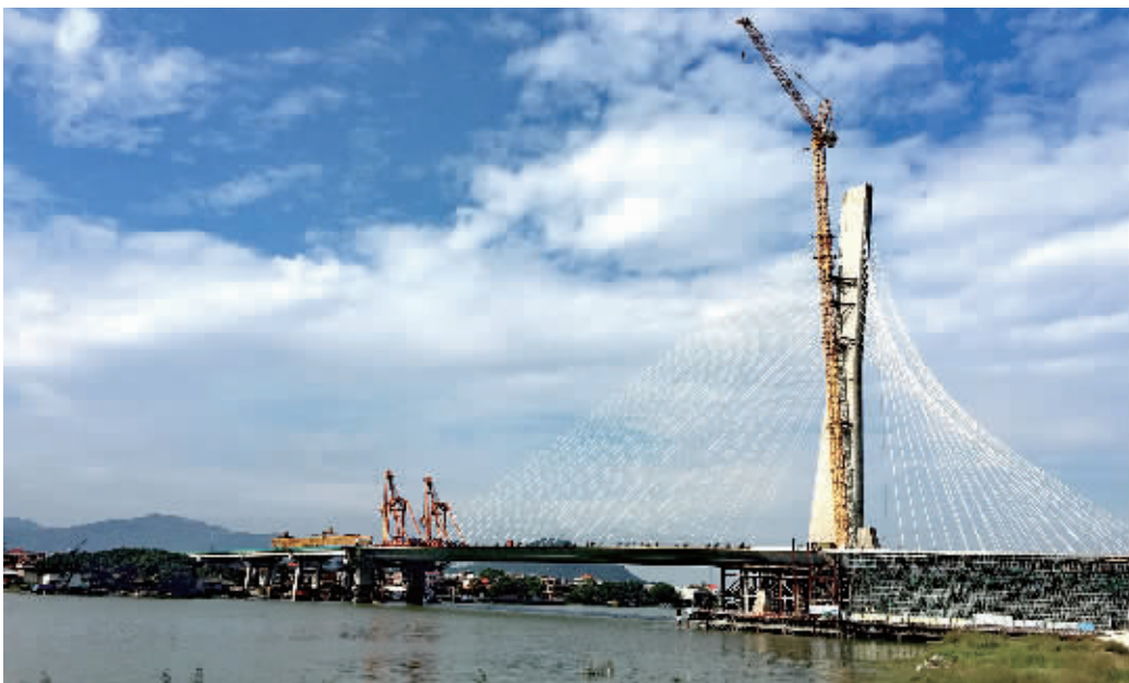
世界最宽单塔斜拉桥合龙
