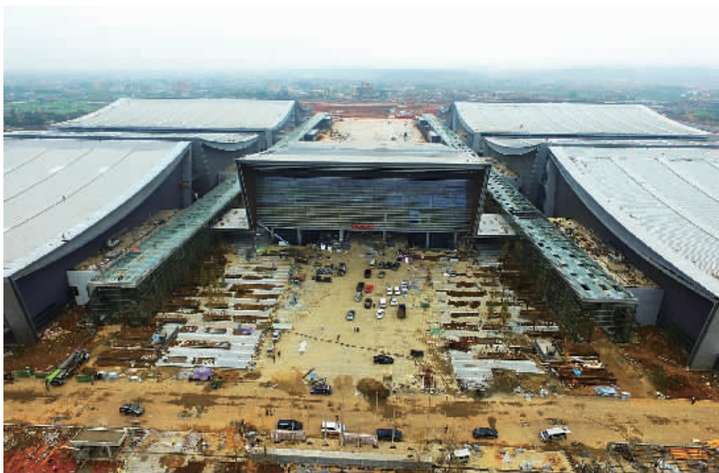
10月24日,长沙国际会展中心建设现场,施工人员进行外围扫尾工作。目前,该项目一期工程已基本完工,计划下月初正式开馆运营。 记者 田超 摄
