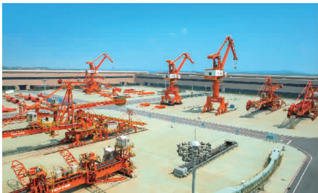
9月9日,湘潭九华工业园,泰富重装20万平方米的露天综合总装调试场地,港机设备高耸入天,巍峨壮观。
