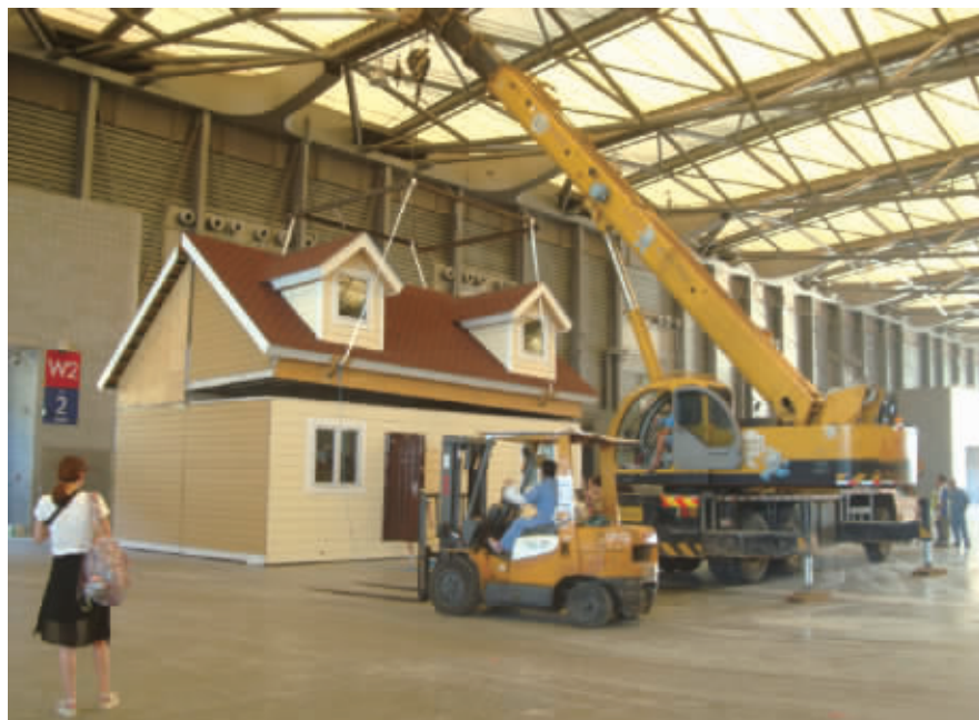
工厂化生产,装配式施工,住宅产业化因其经济环保受到青睐。
