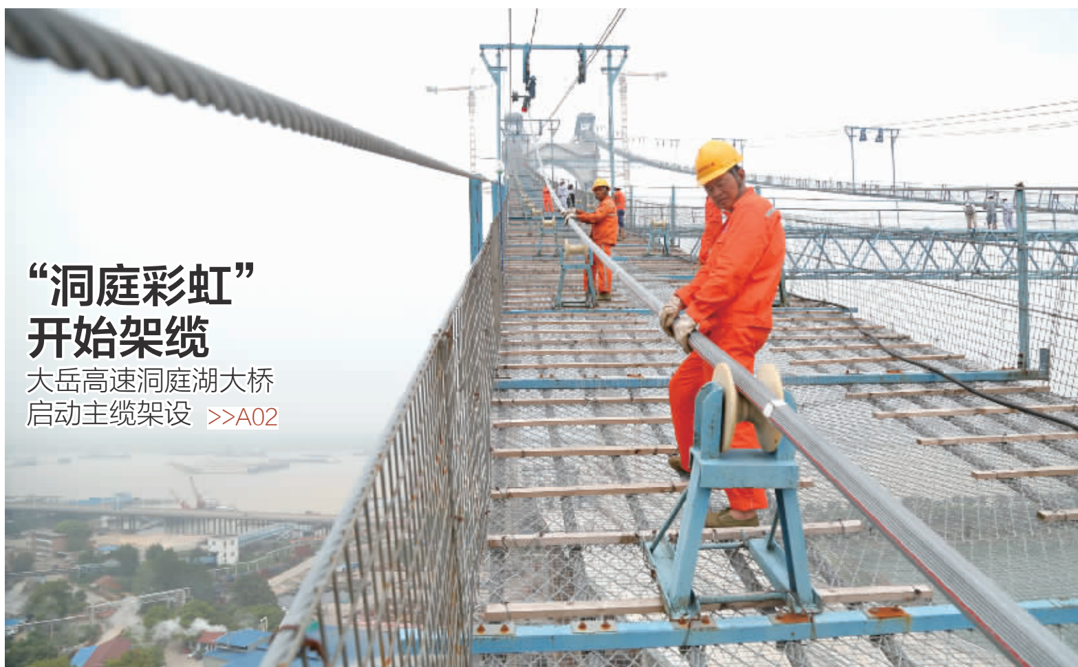
8月22日,国内第一大跨径的钢桁梁悬索桥——大岳高速洞庭湖大桥施工现场,施工人员正在架设索股。大桥主缆所用钢丝总长11.6万公里,可绕地球3圈。记者 徐典波 摄
