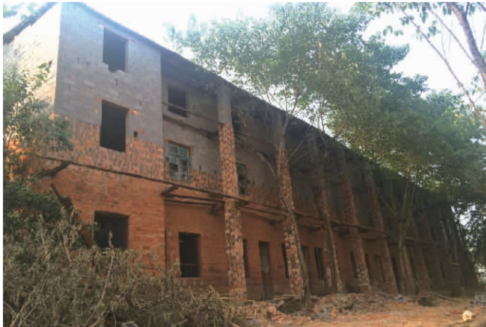
7月22日，记者实地走访，其中一栋尚只拆除1楼楼顶。5天后，加建两层已完工。 见习记者 杨洁规 摄
