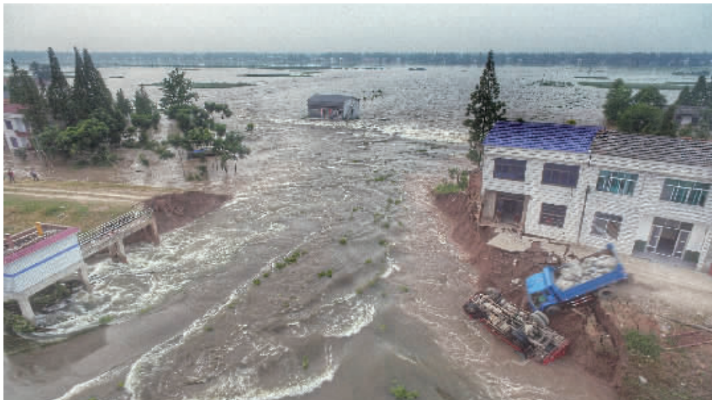
7月10日下午7时开始，华容县新华垸溃口，陆续有来自当地满载土石料的卡车冲入河中，用庞大的车身赌注洪水。司机身绑安全绳在入水前跳车。 记者 童迪 摄
