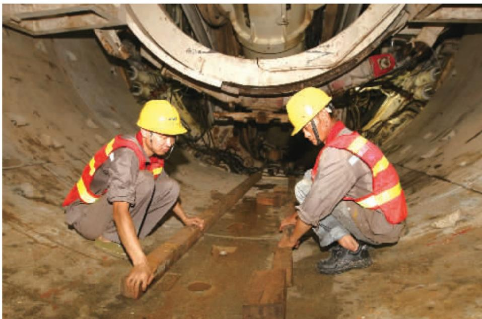
7月31日，施工人员在铺设铁轨和方木，方便盾构机掘进。当天，“先锋号”盾构机在长沙地铁3号线一期工程湘龙站始发，开始其向西掘进旅程。地铁3号线计划2018年通车，目前已陆续开始区间施工，部分车站进入附属结构施工阶段。 记者 赵持 摄
