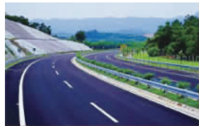
桂阳至临武高速公路项目。
