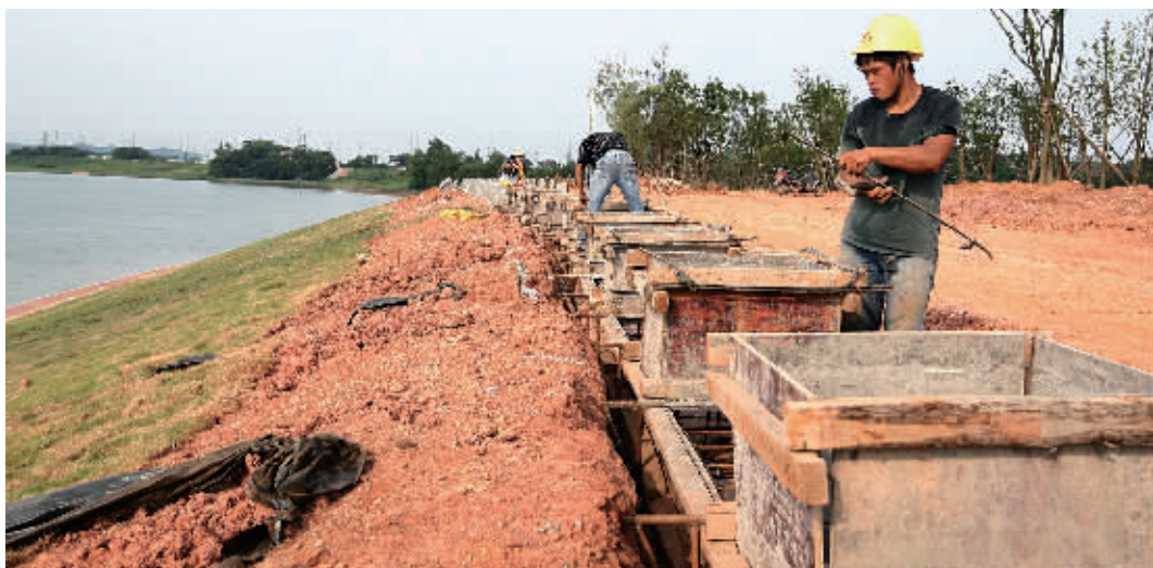
6月22日,长沙县捞刀河南岸,施工人员在加工防浪墙。捞刀河南岸生态治理一期工程去年9月开工,工程整治长度约4.1公里,全线分成生态养息区、城市休闲区、活力体验区、潜存保留区四个区。目前,工程生态养息区乔木种植完成60%,部分区域已在种植草皮;城市休闲区商店、咖啡厅和补助用房等10个建筑的主体已经全部完工,正在进行装饰作业。 记者 赵持 摄影报道
