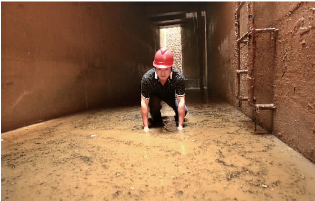
6月14日，长沙市岳麓区徐家湖泵站，工作人员深入16米深的井下检查捞渣情况。当天，长沙市城区排水设施运行服务中心组织工人对全市46座泵站进行清淤和设备检查，迎战新一轮强降雨，防止城市内涝。 记者赵持 摄
