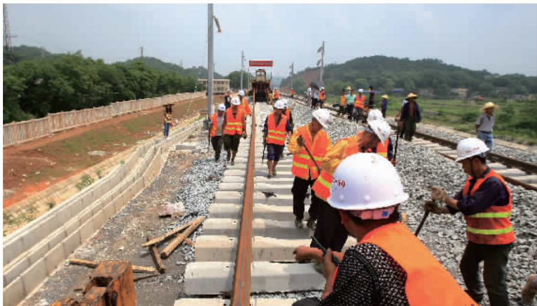
6月13日,株洲市七斗冲站,施工人员在为轨通进行最后冲刺施工。记者 赵持 摄
