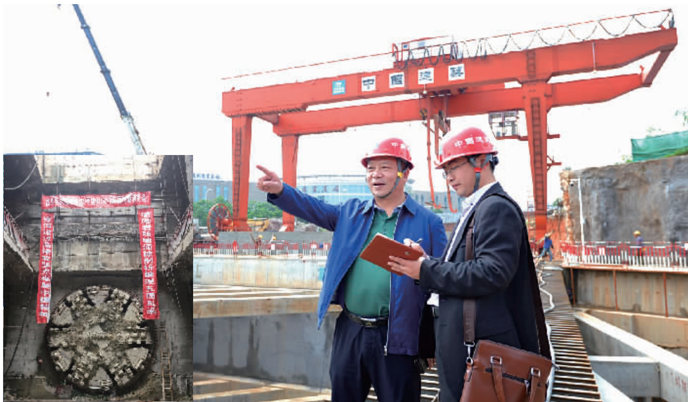
5月10日，长沙地铁4号线溁湾镇站项目现场，中建五局盾构分公司总经理正在指导工作。记者 李健 摄
