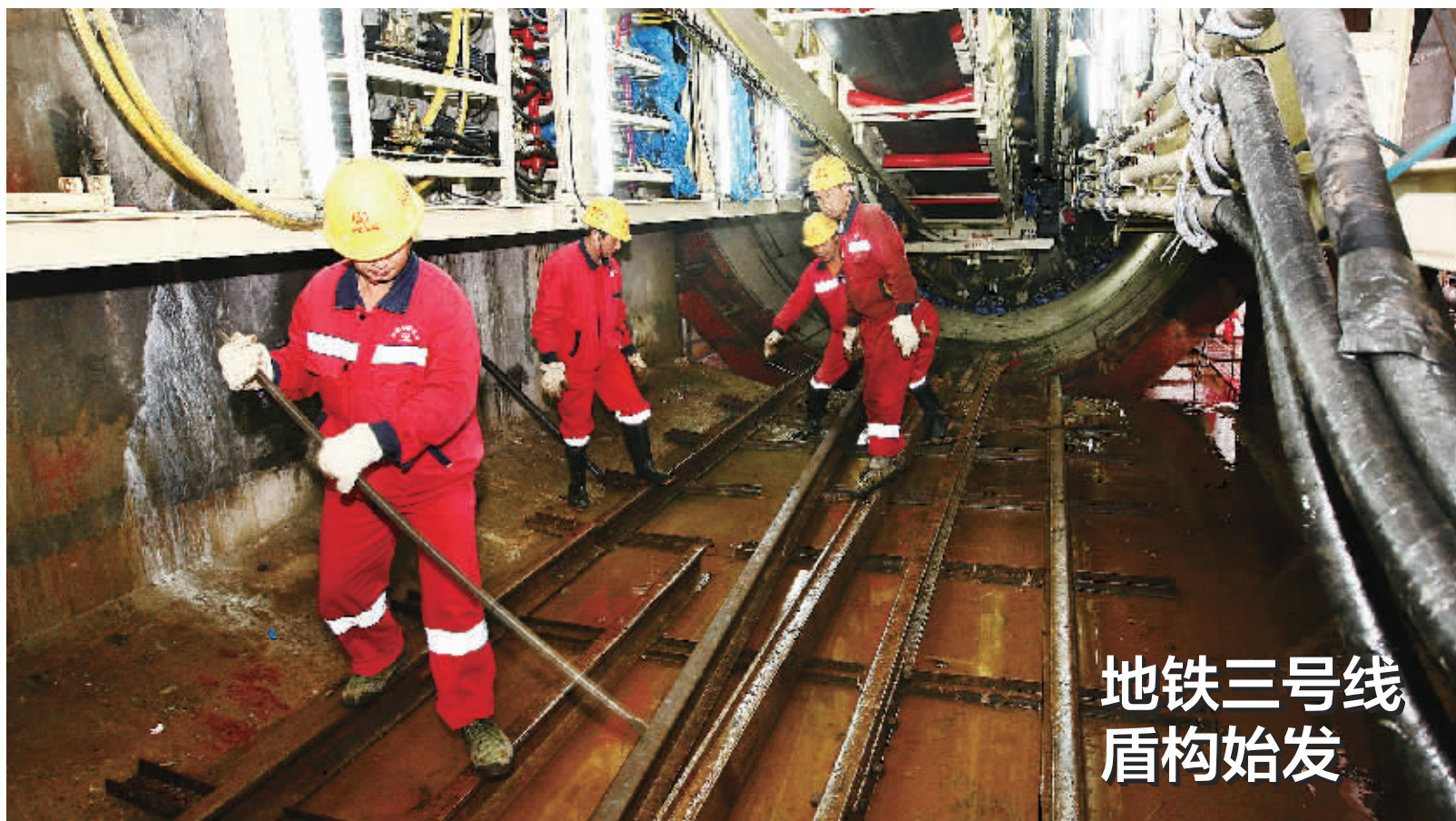
4月25日, 将于2018年底通车的长沙地铁3号线, 施工人员在洋湖新城站铺设盾构机轨道。当天, 盾构机在此站始发, 向北以每月超过200米的速度掘进。 记者 赵持 摄
