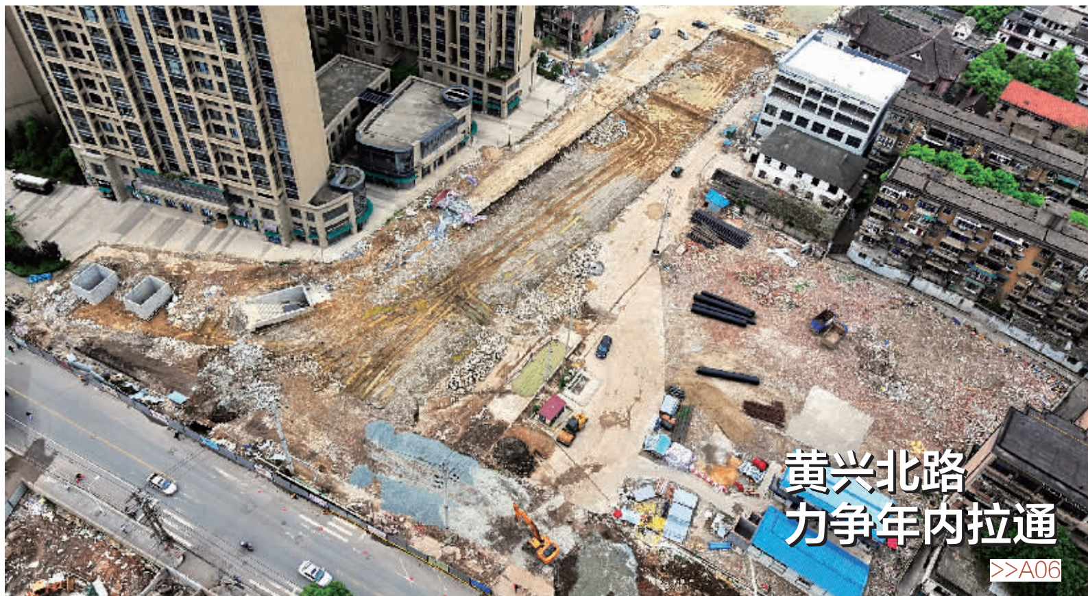
4月14日,长沙市黄兴北路施工现场,施工机械在进行场地平整及土方施工。当天,对接营盘路和三一大道的长沙市黄兴北路正式开建。该路全长约2.5公里,双向六车道宽,设计车速40公里/小时。 记者 田超 摄
