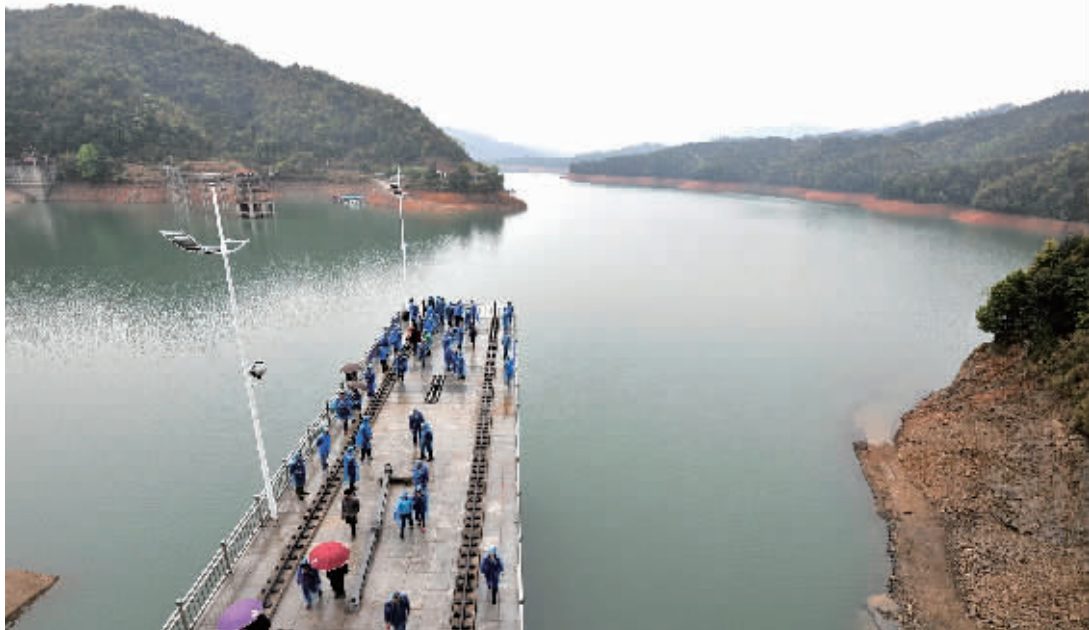
3月26日，长沙市民代表应邀走进浏阳市株树桥水库，探访长沙第二水源，了解长沙引水工程情况。 记者 田超 摄
