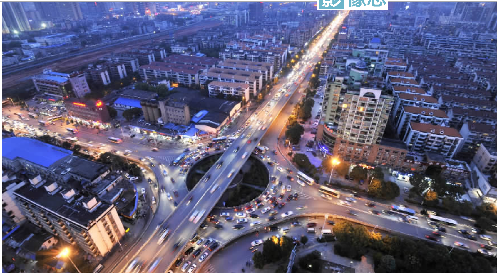
杨家山立交位于长沙市东二环与人民路交会节点，改造前中层环岛的小半径让立交桥变成有名的“堵点”。记者 田超 摄
