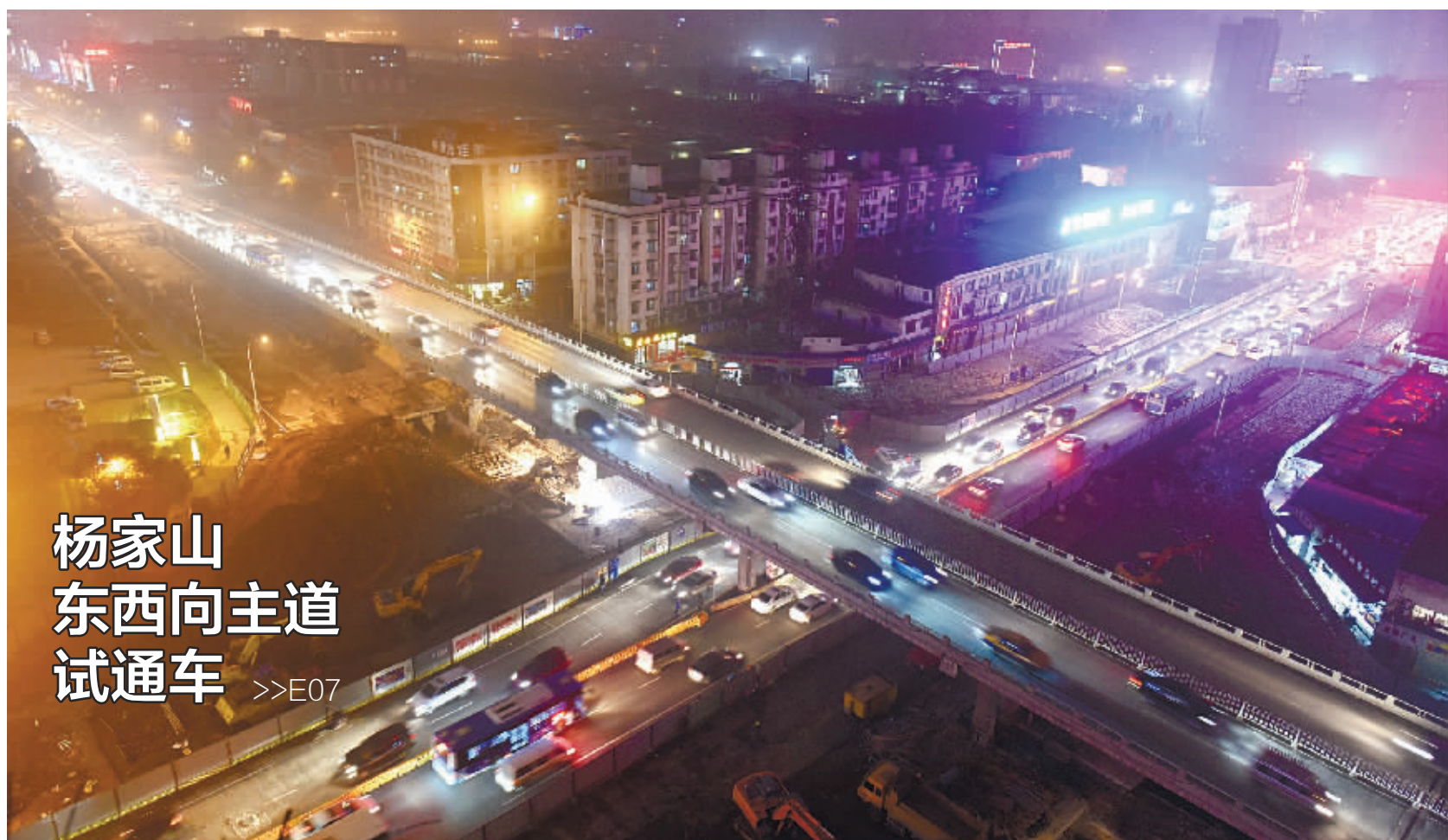
1月12日,长沙市杨家山东西向主道(人民路),车流不息。当天,杨家山立交桥改造工程进入扫尾阶段,东西向主道暂时开放4个车道通行,预计2月2日全部通车。届时,杨家山立交桥将变成一座跨线桥,桥上保持双向4车道,桥下东西向拓宽成双向10车道、南北向为双向8车道。 记者 唐俊 摄
